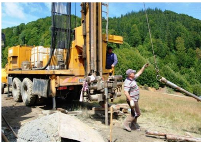
Fig. 9 - Foraj geotehnic pe berma superioară
