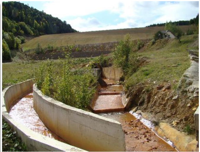
Fig. 8 Privire spre paramentul aval al barajului principal – Iazul de decantare Tărnicioara
